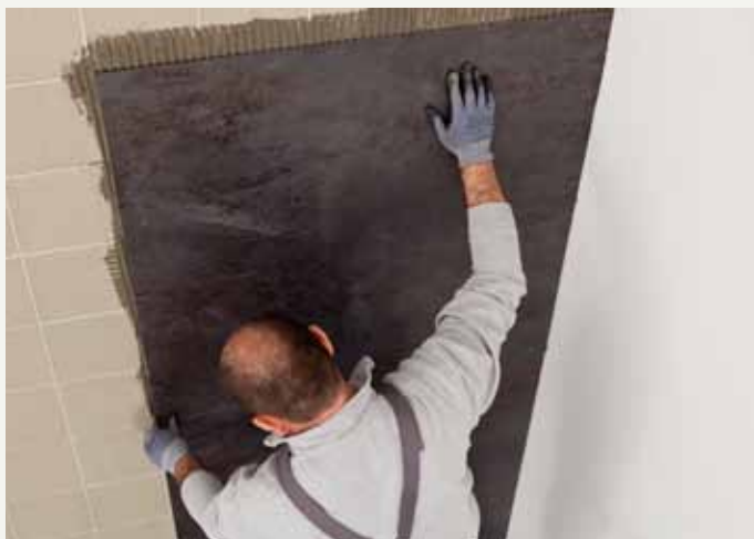
fig.38 / Posa della lastra. / Application of the slab.
